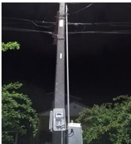
Instalación de Relojes Astronómico
